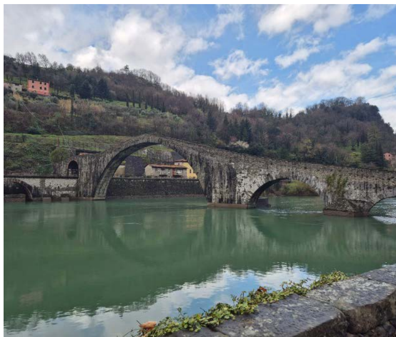
Figure 32 : Pont du diable (Devil's bridge). Source : auteurs.
